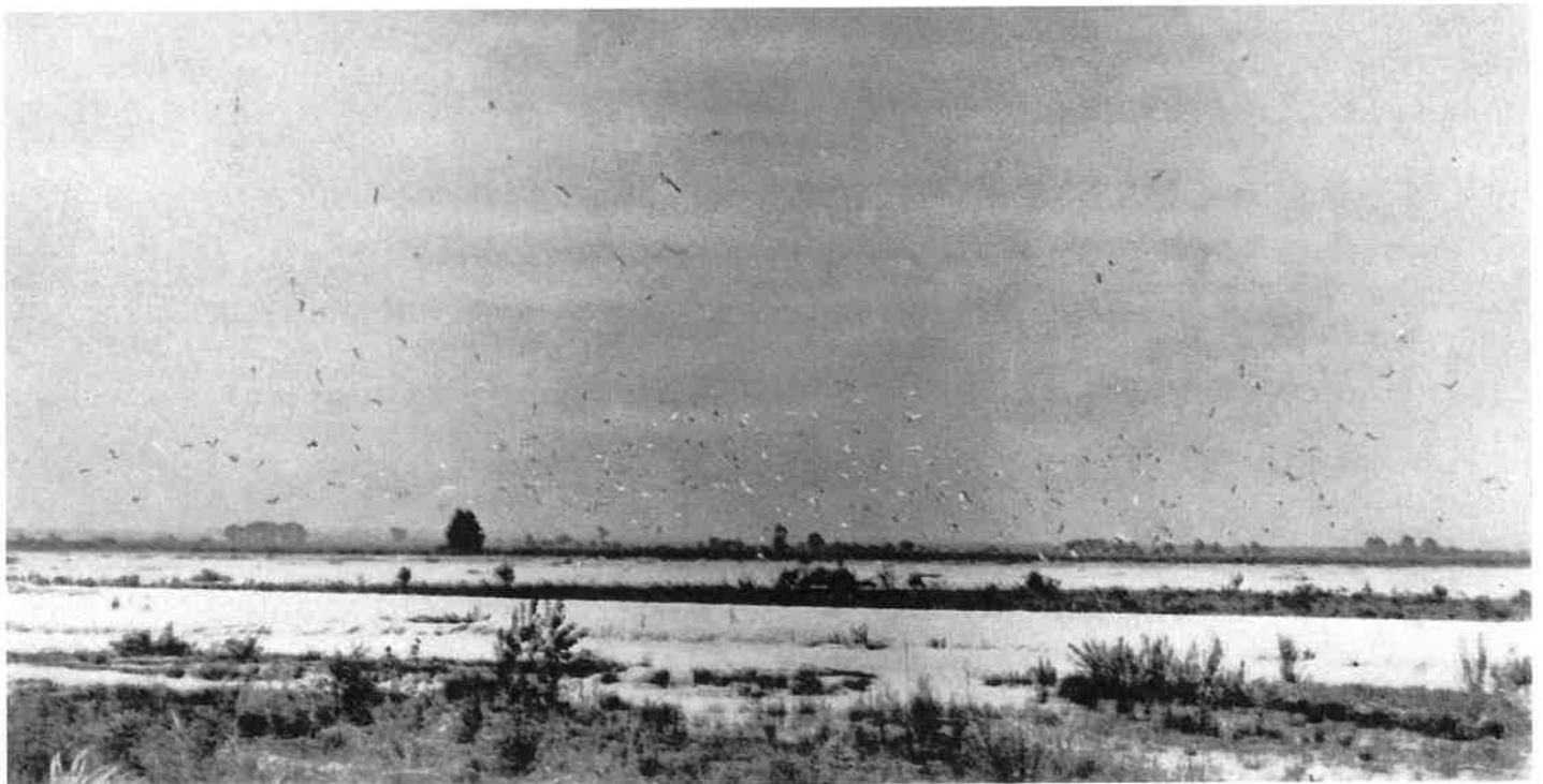
26. Am Lochbachanstich, etwa km 59.5, Blick nach Osten (15.05.1915).
