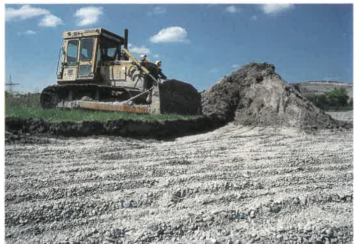
Abb. 26: Freilegung der natürlichen Schwemmkiesfläche als vorbereitende Puffer- und Sukzessionsfläche der Heide. Foto K.R. Schmidt 1991.
