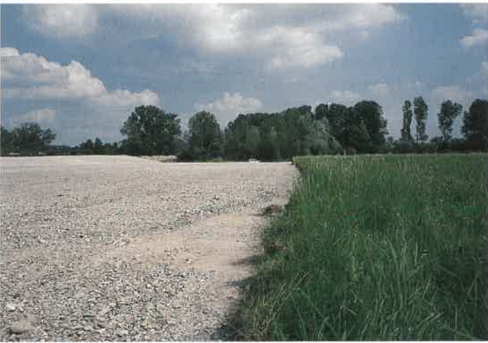
Abb. 30: Sommer 1991: Vorbereitungsarbeiten für die Sukzessionsfläche der Firnhaberan-Heide. Foto D.D. Schmidt.
