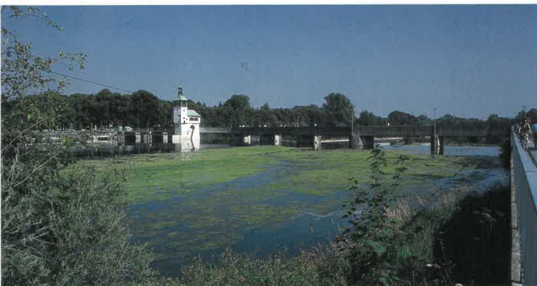
Abb. 10: Algenteppich vor dem Hochablaß im Sommer 1990. Ursachen: Nährstoffanreicherung, Verringerung der Fließgeschwindigkeit und Erwärmung des Lechwassers durch Flußbaumaßnahmen. Foto K.R. Schmidt 1990.
