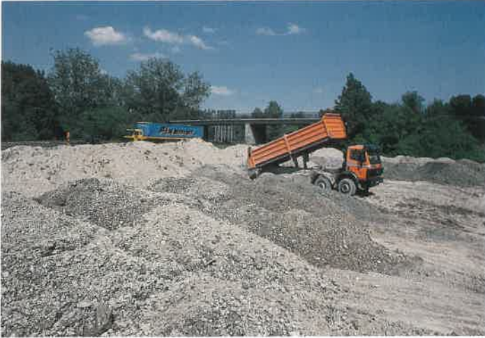
Abb. 29: Schütтарbeiten für den Lärmschutzwall südlich der Autobahn. Foto K.R. Schmidt 1991.
